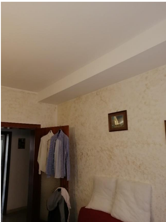
Copertura canali con veletta in cartongesso
