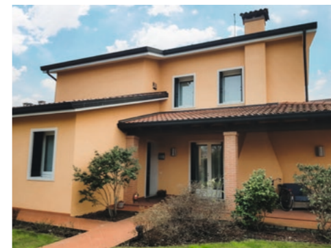
Ristrutturazione a Vicenza
