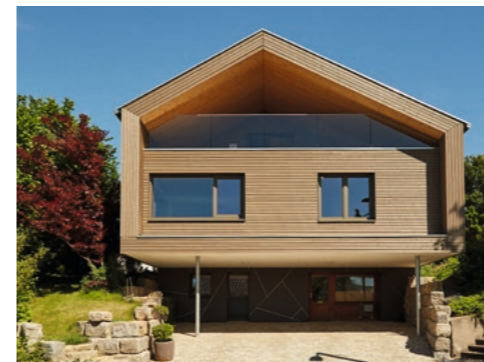
Casa unifamiliare ristrutturata
