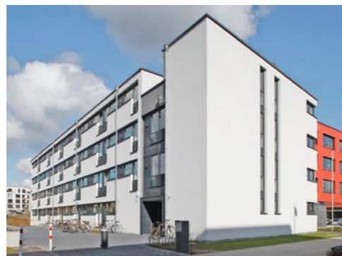
Casa dello studente Campus Riedberg
