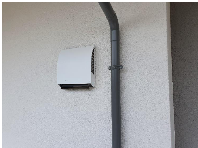
Guscio esterno in acciaio con finitura bianco tintegegiabile
