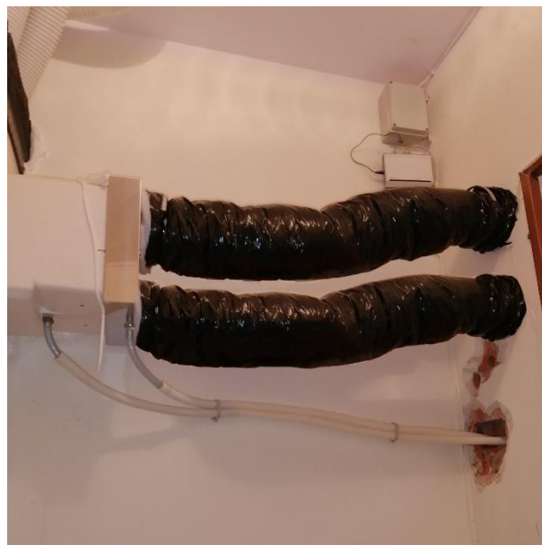
Tubi isolati per ripresa e per espulsione Consigliati su installazioni di questo tipo
