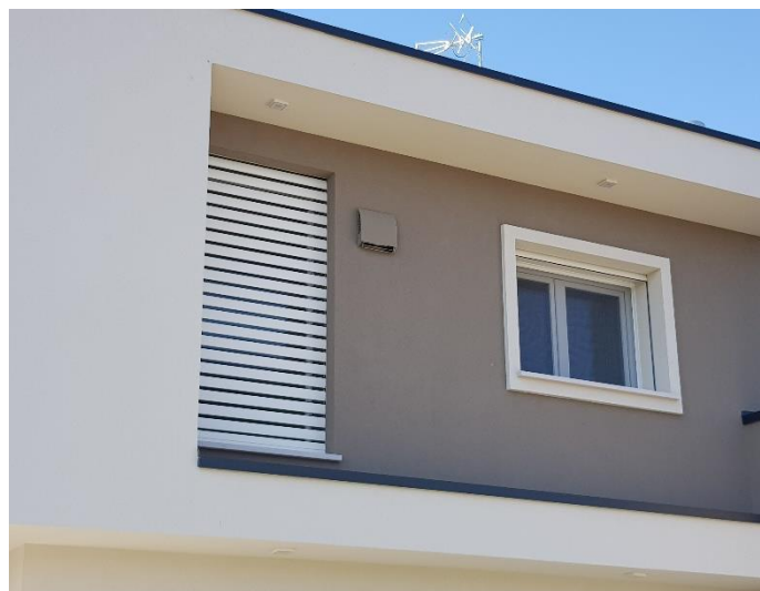
Guscio in acciaio colorato con la stessa tinta della parete
